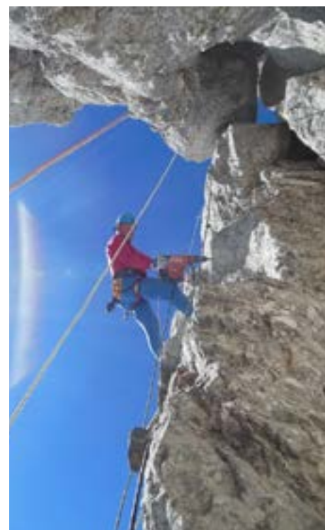
Osrednji del, prehod vertikale v kaminu, ki sta ga tehnično nadelala in opremila člana tehnične skupine KPP PZS, je postal opremljen z jeklenico in lestvenimi klini, foto Edo Tomšič
